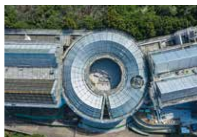
工事中の広島市現代美術館 撮影: 花田ケンイチ
