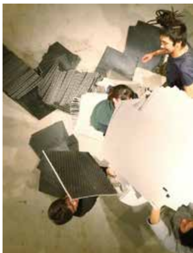
張り替え予定のカーペットを剥がし、積み上げる。
